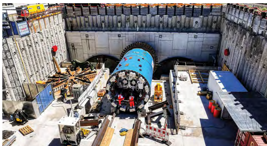
Erste Tunnelbohrmaschine der 2. Stammstrecke der S-Bahn München (Foto: DB).
