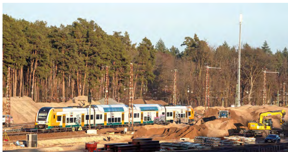
Umbau Bahnhof Fangschleuse im Februar 2026 (Foto: DB/Volker Emersleben).
