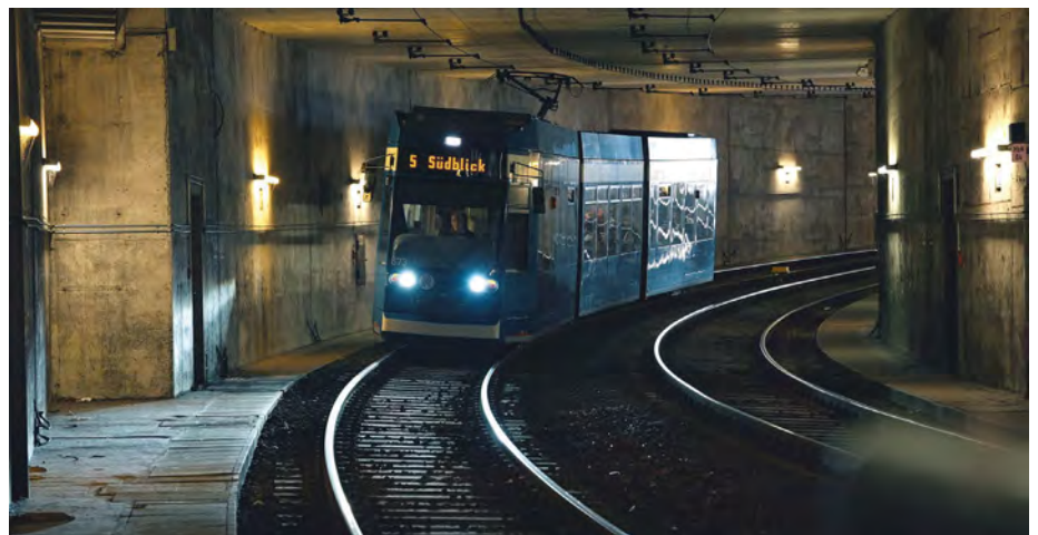
Tunnelstrecke der Rostocker Straßenbahn (Foto: Siemens).
