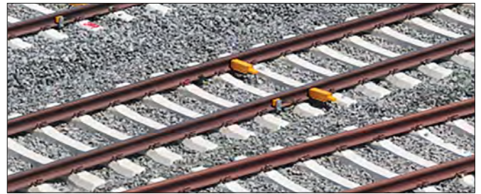
Akustiksystem zur Erkennung von Schienenbrüchen (Foto: Enekom).
