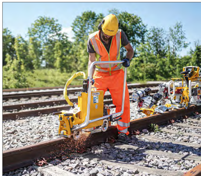
Die Schienenkopf-Schleifmaschine ROGRIND 13.45 RS E 3 (Foto: Robel).
