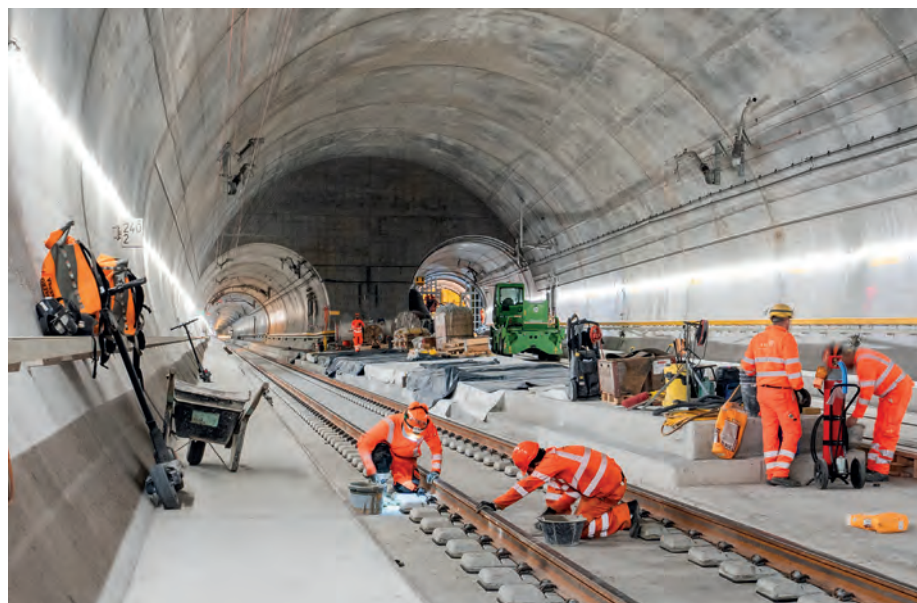
Nach dem Unfall im GBT: Arbeiten am neuen Spurwechsellor (Foto: SBB/Gian Baeriswyl).
